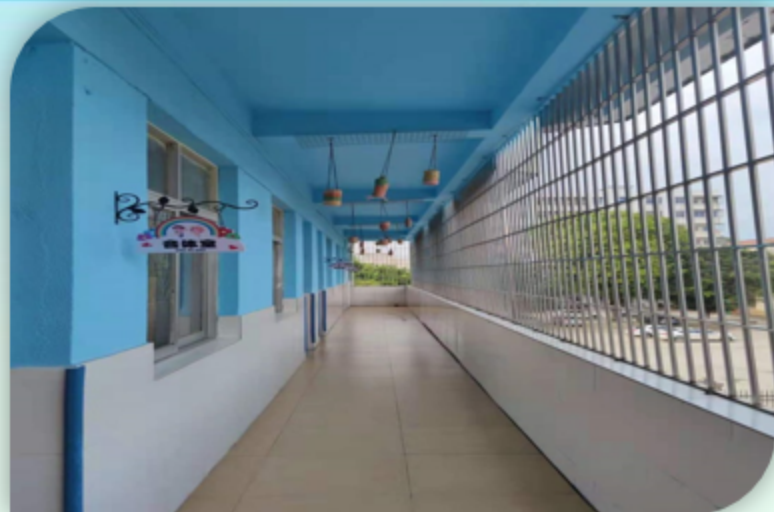
翻新后的教学楼
