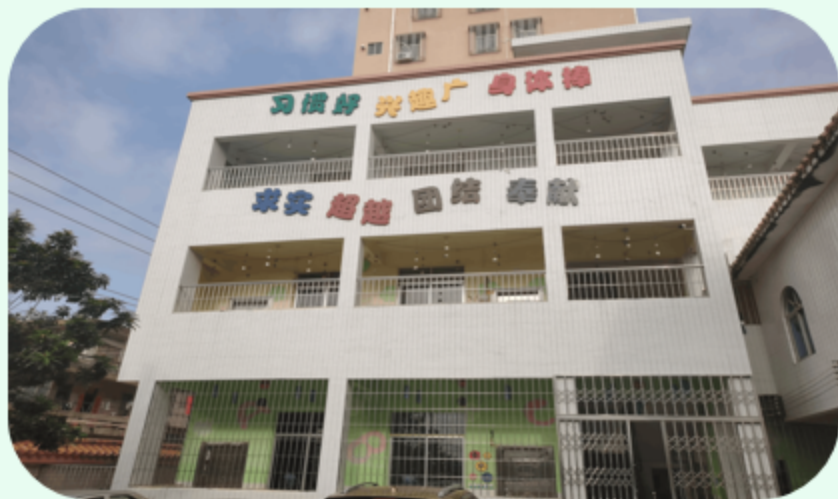
2017年9月投入使用—岭北镇中心幼儿园
