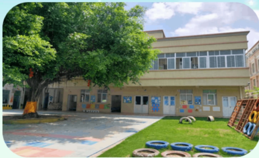
2016年2月投入使用—城月镇中心幼儿园
