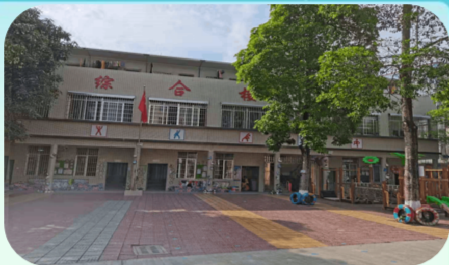
2019年9月投入使用—杨柑镇中心幼儿园
