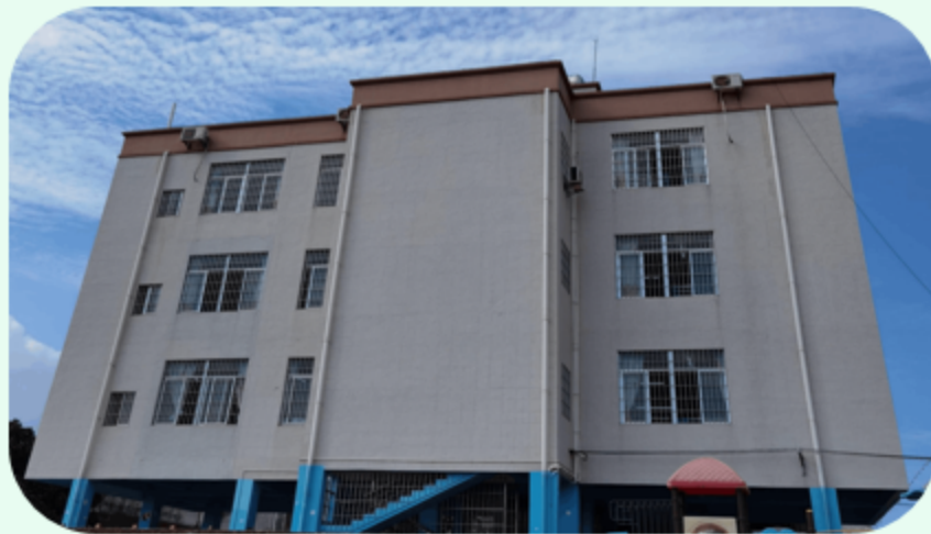
2016年9月投入使用—江洪镇中心幼儿园
