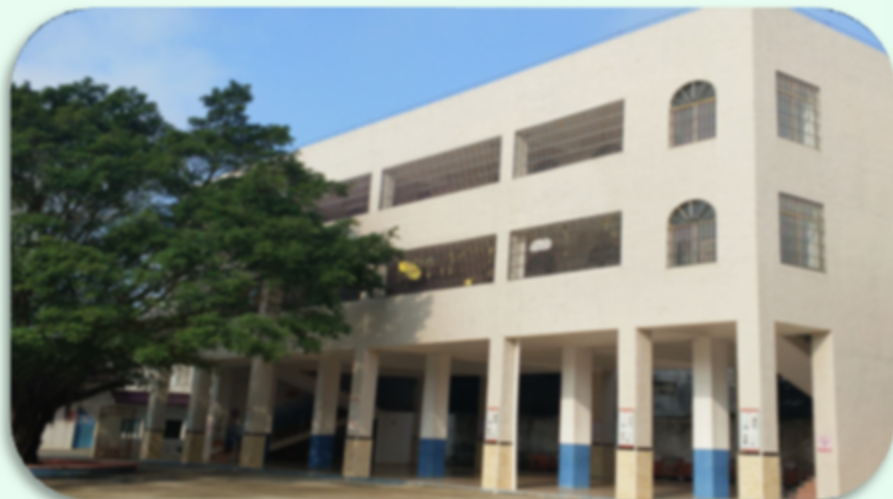
2018年9月投入使用—北坡镇中心幼儿园
