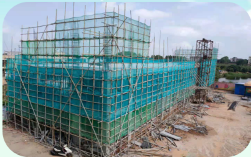
2021年在建项目—乌塘镇中心幼儿园
